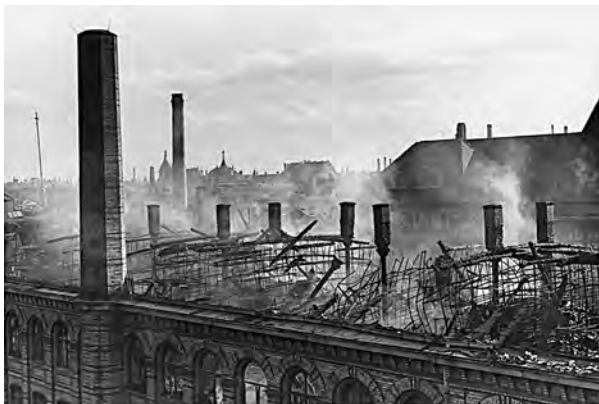
Das Firmengebäude nach den Bombenangriffen 1943
