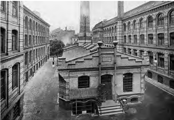
Innenhof mit Maschinenhaus
